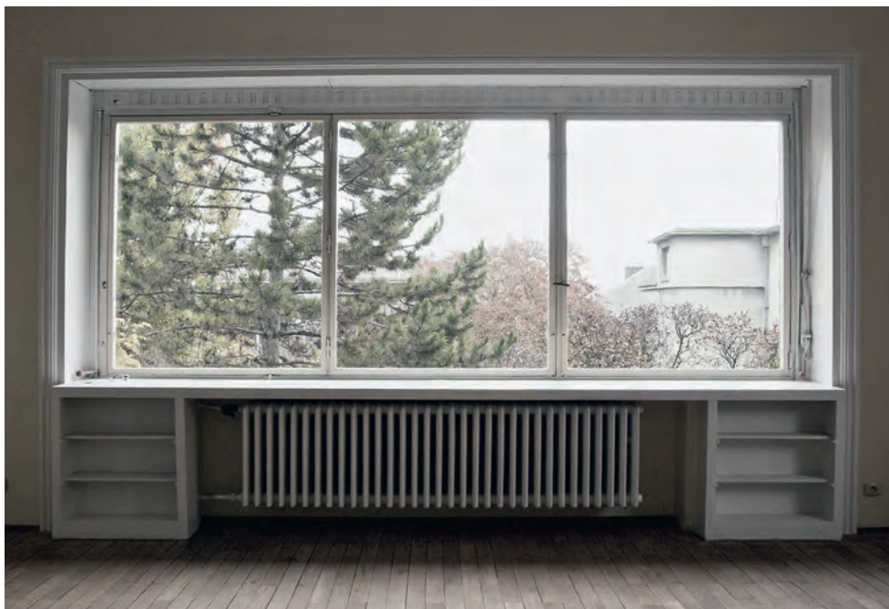
Abb. 7: Kraus-Stahlfenster, Villa Lengye, Bratislava, aktueller Zustand
