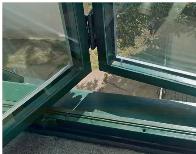
Abb. 6: Kraus-Stahlfenster nach der Restaurierung, Masaryk-Studentenhaus, Brno
